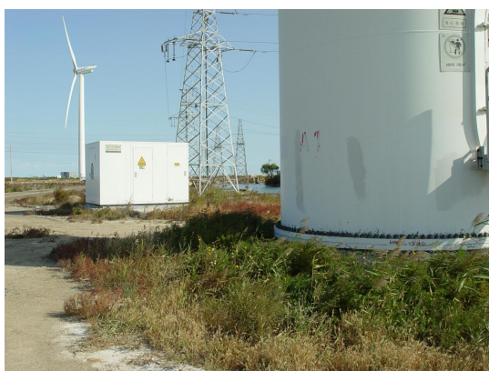
风机和箱变基础平整覆土，播撒草种及靠自然恢复植被；道路边坡喷浆硬化，路边播撒草种恢复植被。
