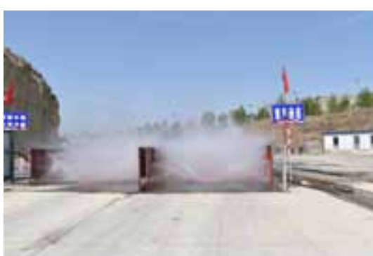
作业区出入口设置车辆冲洗装置
