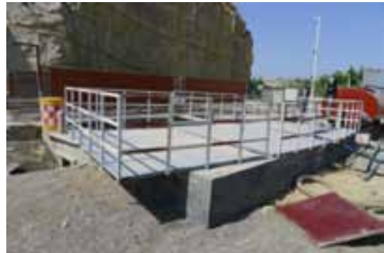
车辆冲洗装置旁设车辆冲洗水收集沉淀池，车辆冲洗废水经沉淀后回用于矿区道路洒水抑尘，不外排。
