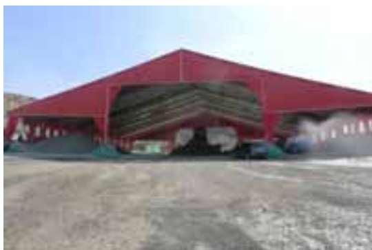
破碎筛分系统设置在棚内，棚顶及破碎筛分系统自带喷雾洒水装置，不间断喷雾洒水，始终保持棚内处于湿润状态，极大减少了粉尘的产生。
