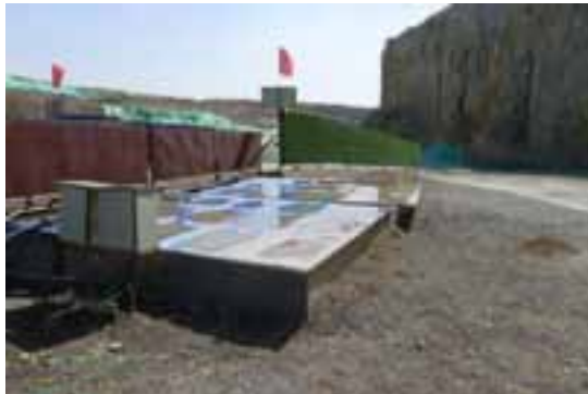
车辆冲洗装置旁设车辆冲洗水收集沉淀池，车辆冲洗废水经沉淀后回用于矿区道路洒水抑尘，不外排。
